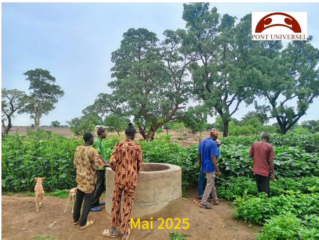
Réhabilitation du puit du GS de Dakigou
